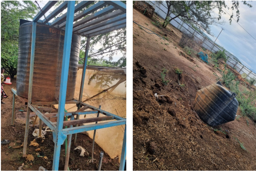
Fig 1(d): Wassertanks im Garten. Nur einer von 3.000 Litern steht noch. Der zweite wurde vom Wind weggeblasen und ist zerbrochen. Wenn das Projekt ausgeweitet wird, benötigt es zusätzliche und größere Tanks, um mehr Wasser zu speichern.
