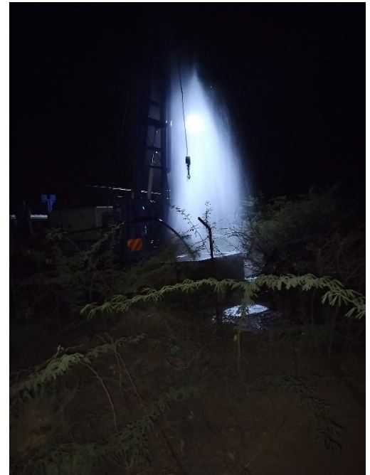
Fig 1(b): Reparatur und Wartung des Umoja-Bohrlochs im Oktober nach 7-jährigem Betrieb zur Wiederherstellung seiner normalen Kapazität
