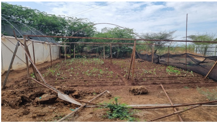
Fig 6: Ein offener Garten ohne physische Barriere ist anfällig für das Eindringen von Eichhörnchen und unbefugten Zugang. Es benötigt eine Schattennetz-Barriere
