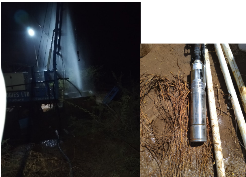
Fig 1(c): Reparaturplattform am Umoja-Bohrloch für Reparatur- und Wartungsarbeiten im Oktober: Austausch von Stromkabeln, Wartung der Tauchboote und Ausspülen von Salz aus dem Bohrloch zur Wiederherstellung der normalen Kapazität
