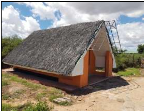
Bild 14: Die ersten beiden alten Bandas, die im Rahmen des Renovierungsprogramms vor der Flut renoviert worden waren, wurden nun mit Stahlkonstruktionen aus Baldachin und PVC-Baldachin mit Derins-Schnur ummantelt. Dies soll die Gipsdecke der Veranda vor Regenwasserzerstörung schützen. Dasselbe ist für die beiden neu renovierten Bandas erforderlich und wird installiert, sobald wieder Ressourcen verfügbar sind.
