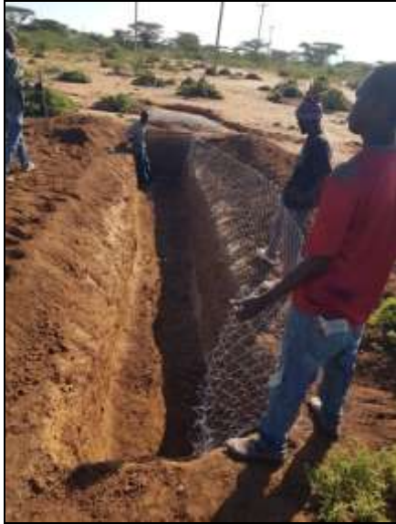
Bild 9: Gabion/ Steinwall Fundament mit Kiesfüllung
