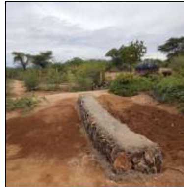
Bild 10: Der Prozess der Erstellung der Steinwälle, zum Abschluss mit Beton versiegelt. An den Seiten wird kein Beton aufgetragen, da das Durchlassen von Wasser die Geschwindigkeit verringert. Mit der Zeit werden die Zwischenräume mit Sand gefüllt.
