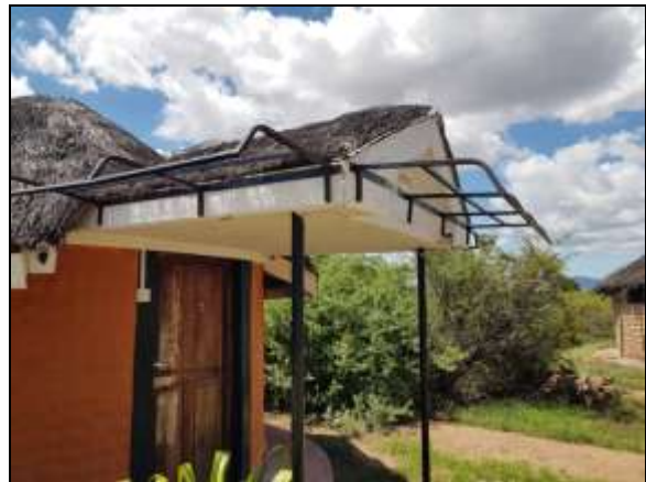
Bild 14: Die ersten beiden alten Bandas, die im Rahmen des Renovierungsprogramms vor der Flut renoviert worden waren, wurden nun mit Stahlkonstruktionen aus Baldachin und PVC-Baldachin mit Derins-Schnur ummantelt. Dies soll die Gipsdecke der Veranda vor Regenwasserzerstörung schützen. Dasselbe ist für die beiden neu renovierten Bandas erforderlich und wird installiert, sobald wieder Ressourcen verfügbar sind.
