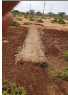
Bild 10: Der Prozess der Erstellung der Steinwälle, zum Abschluss mit Beton versiegelt. An den Seiten wird kein Beton aufgetragen, da das Durchlassen von Wasser die Geschwindigkeit verringert. Mit der Zeit werden die Zwischenräume mit Sand gefüllt.
