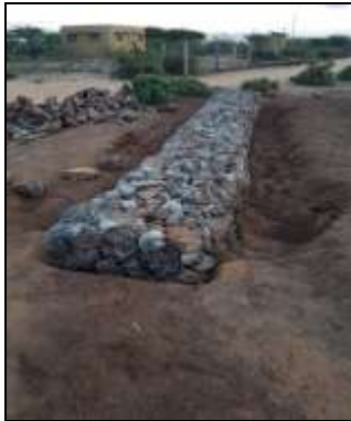
Bild 10: Der Prozess der Erstellung der Steinwälle, zum Abschluss mit Beton versiegelt. An den Seiten wird kein Beton aufgetragen, da das Durchlassen von Wasser die Geschwindigkeit verringert. Mit der Zeit werden die Zwischenräume mit Sand gefüllt.
