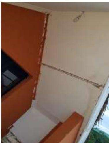
Bei diesem neu renovierten Banda war die Verandadecke aus Regipsplatten dem Regen ausgesetzt, als der Wind den Regen stark in Richtung der Tür blies und einen Teil der Decke durchtränkte und Farben und Gesims abzulösen begannen; auch Teile der Decke an den Rändern begannen sich vom Dach zu lösen.
