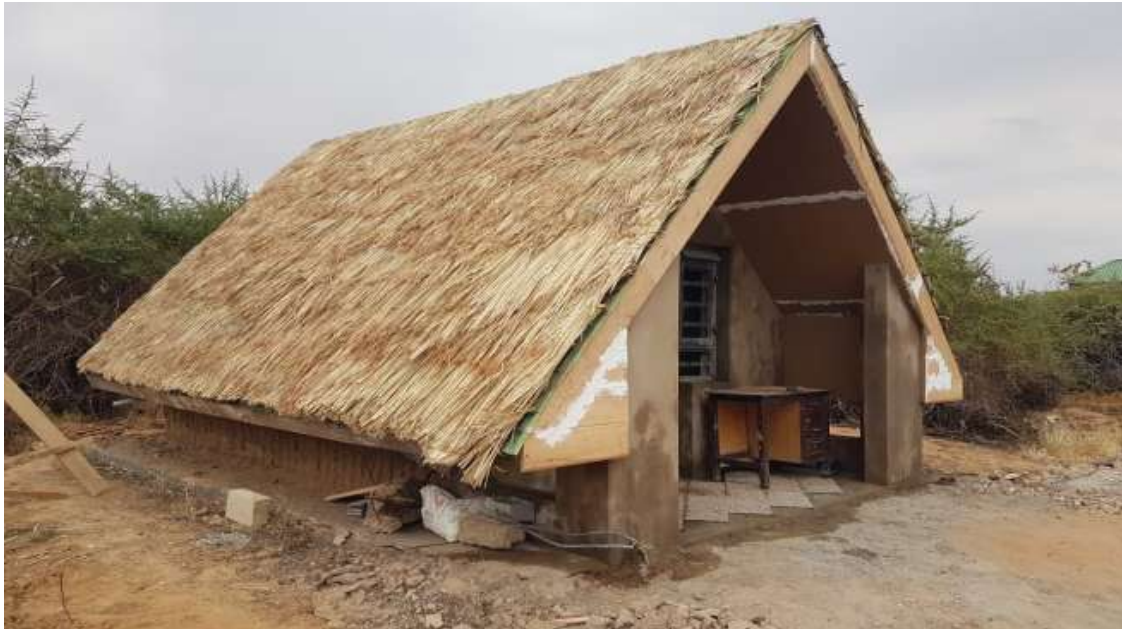
Außenrenovierung incl. Dachreparatur.
