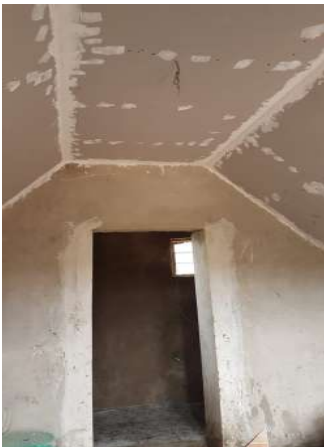
Decken aus Regipsplatten werden eingezogen und die Saniitranlagen komplett erneuert.
