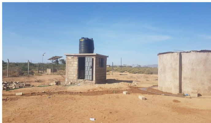
Fig 2: Gebäudeeinheit der Entsalzungsanlage mit Kunststofftank auf dem Dach
