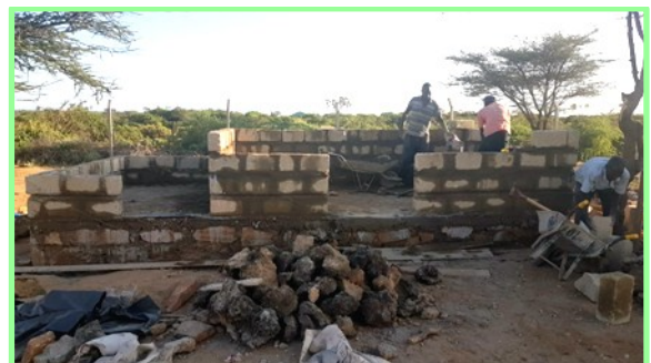
Rohbau mit Unterteilung für die Lagerräume
