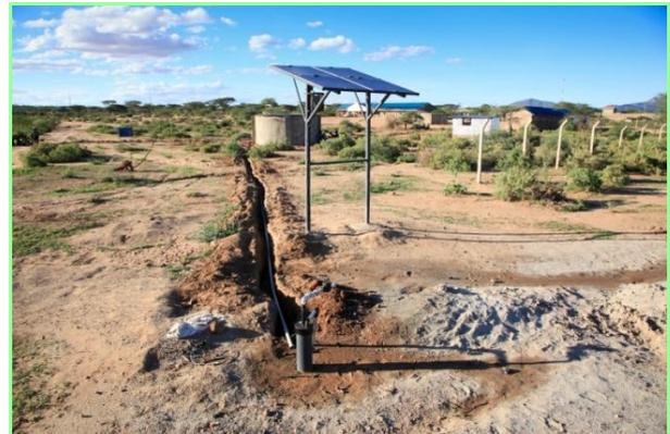
Solarpanel, Wasseruhr mit Verteilerstation sowie Verlegung von Leitungen zu 4 Zapfstationen auf dem Dorfgelände
