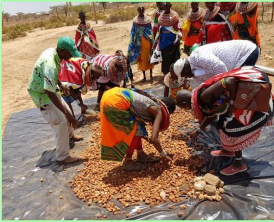
Sandschicht aufbringen, Rohrsystem verlegen und Folie auslegen. Kieselsteine auf Folie verteilen.
