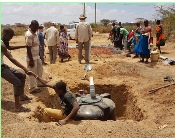
Nun ist auch der Tank angeschlossen für das Wasser-Recycling-System.
