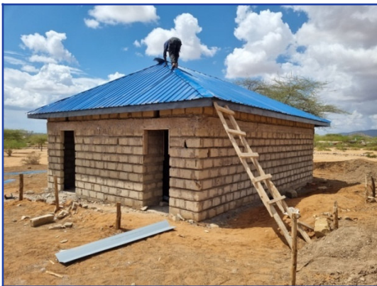
Rohbau mit Dachstuhl - Stand 15.11.2022
