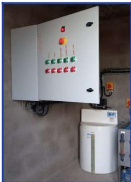
Die Pumpe für das gefilterte Wasser war defekt und wurde ersetzt. Die alte Pumpe kann repariert und als Reservepumpe vorgehalten werden. Eine Schalttafel für die bessere Steuerung und Kontrolle der Anlage wurde eingebaut und die Anlage geerdet.
