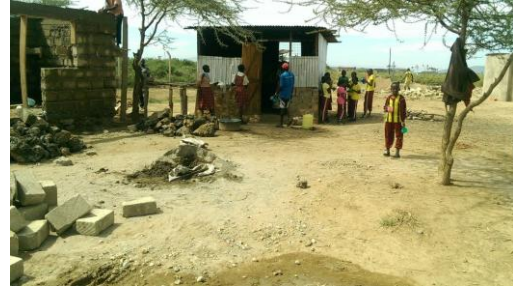
Bau des Lager- und Kühlraumes
