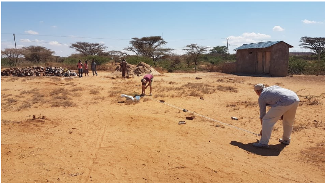
Baubeginn – Bodenmarkierung. Im Gebäude im Hintergrund befinden sich die alten Toiletten.
