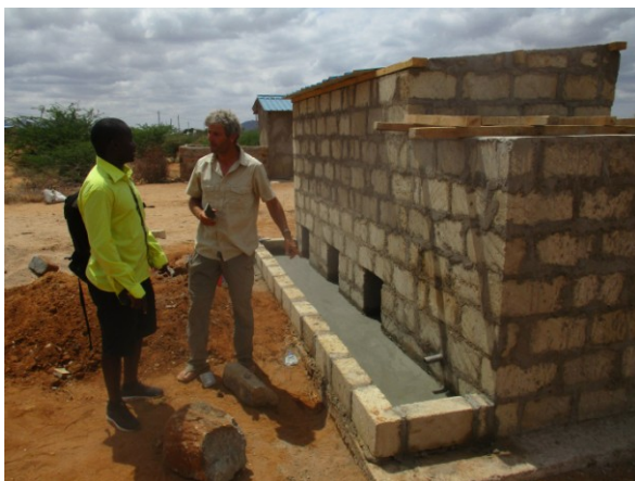
Abflusssrinne zum Faulbeet
