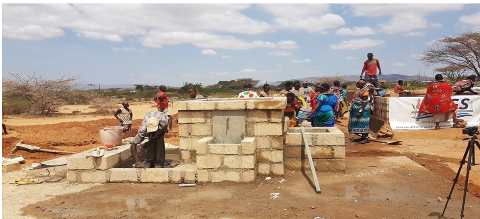
Waschplatz im Bau
